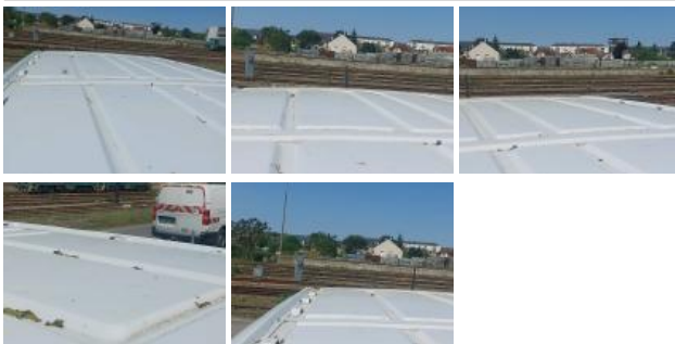
Pavillon caisse, Grêlé, LI - Réparer et peindre (complet)
