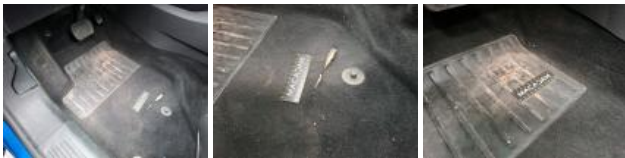
Ciel de toit, Déchirure, Réparer/rempl. (montant forfaitaire)
