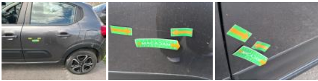
Porte ARG, Griffe(s), Lustrage
