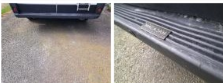
Renfort pavillon AR (au dessus portes AR), Bosse(s), LI - Réparer et peindre (complet)
